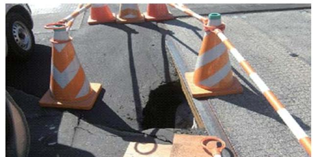
大雨による路面陥没
