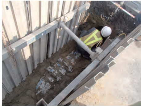
土止め支保工の確実な設置
