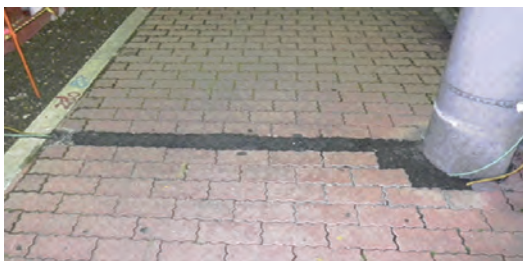
地中にケーブルが埋め込まれている
