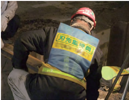
先行手掘り作業の監視人
