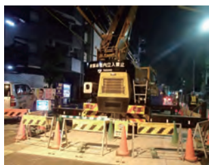
重機作業エリアと作業員作業エリアの区画分け
