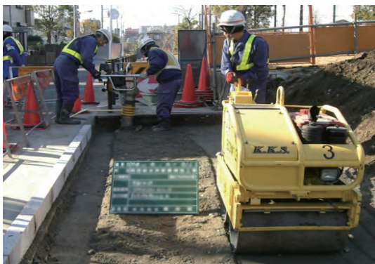
ローラーと作業員による締固め作業 (輻輳する作業は非常に危険)
