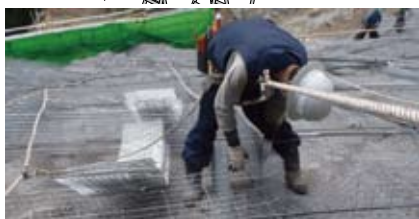
法面作業中の安全帯使用例
