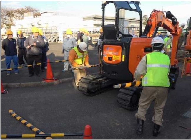
取付状況①
