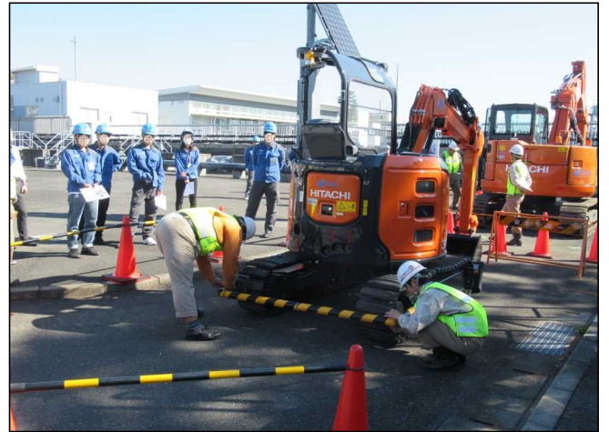
取付状況②
