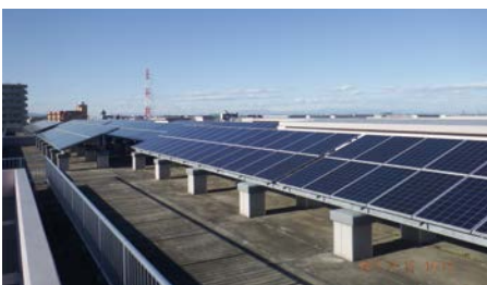
太陽光発電設備（朝霞浄水場）
