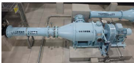
小水力発電設備（江北給水所）
