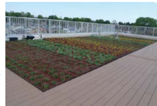
屋上緑化 (羽村取水管理事務所)
