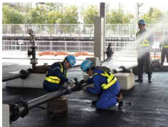
▲ 漏水修繕実習エリア
