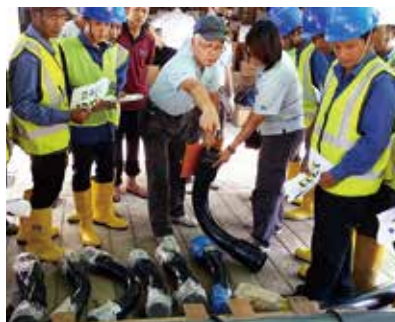
▲ ゴム輪型塩ビ管接合研修(ミャンマー)
