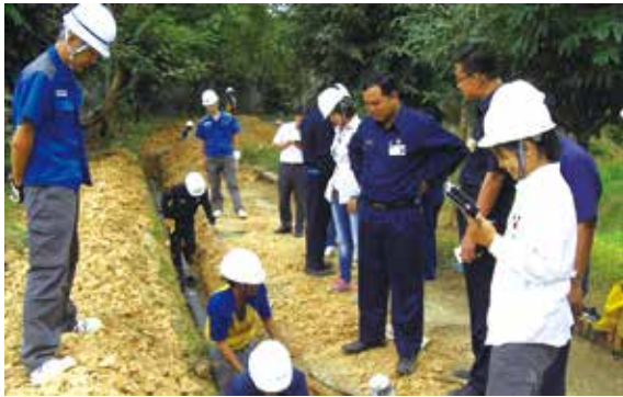
▲ 水道管取替の様子
