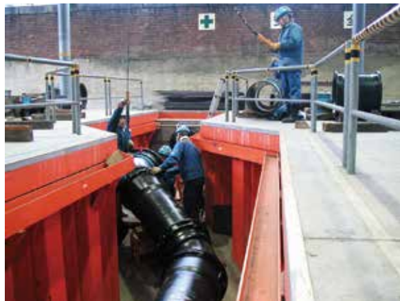
▲ 配水管接続の実習
