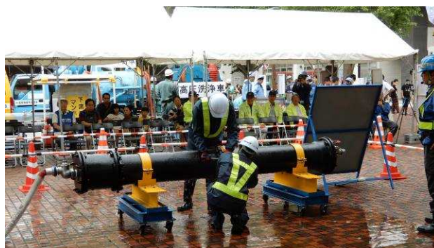
TSSによる漏水管応急復旧
