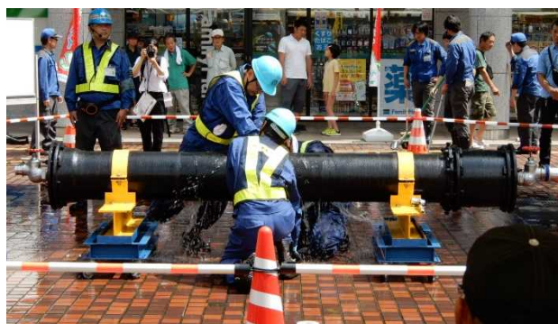
三多摩管工事協同組合による漏水管応急復旧
