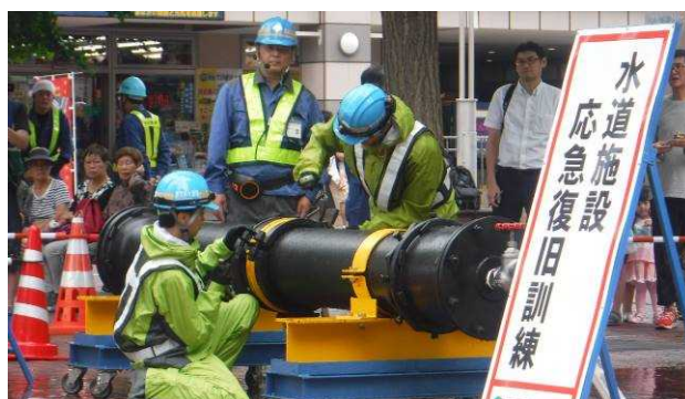
多摩給水管理事務所による漏水管応急復旧
