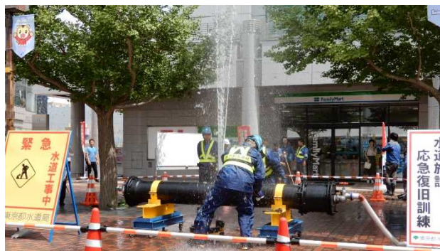
水道緊急隊による漏水管応急復旧
