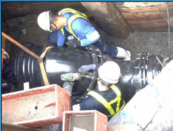
配管工事 （管据付け、接合）
