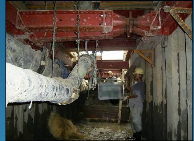
仮設工事の留意点 （他企業埋設物防護）
