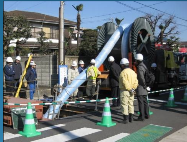
いろいろな管布設工法 （SDF工法）
