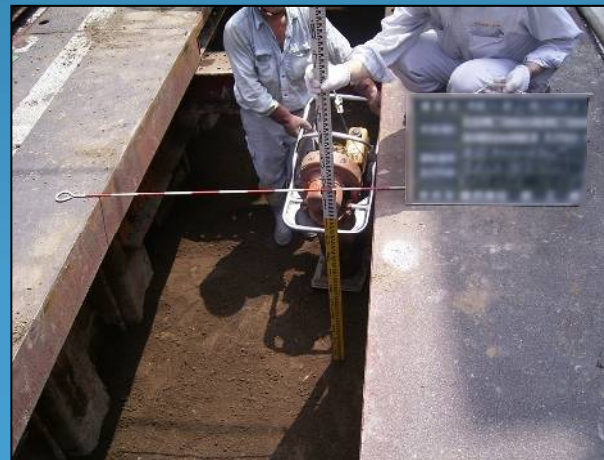
品質管理 （埋戻し仕上り厚計測）
