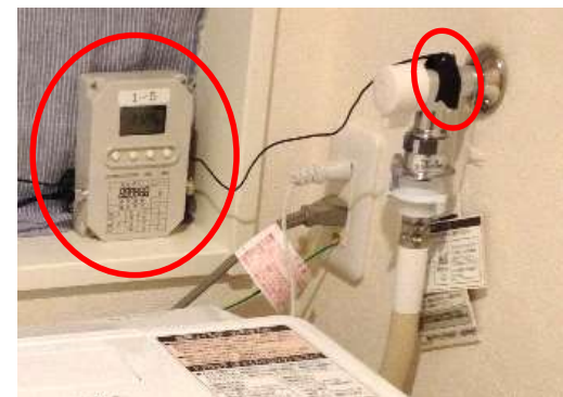
写真 測定機器設置の様子
