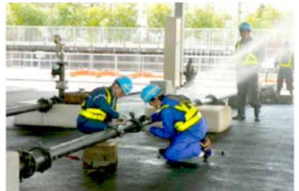
Leakage Prevention Training Area 漏水防止研修等実施工エリア
