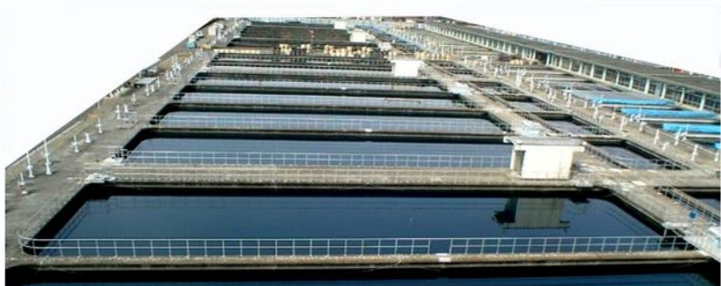
水面が開放されている沈殿池
