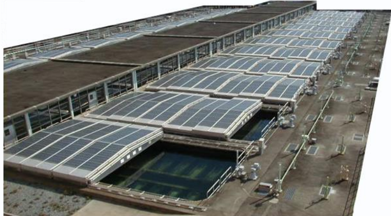
覆蓋化されたろ過池
