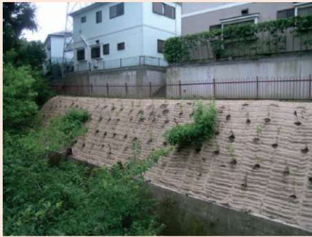
▲水路・法面の保全
