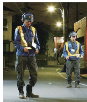
▲漏水発見作業
