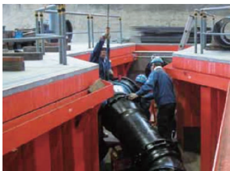
▲配管実習施設（研修・開発センター）
