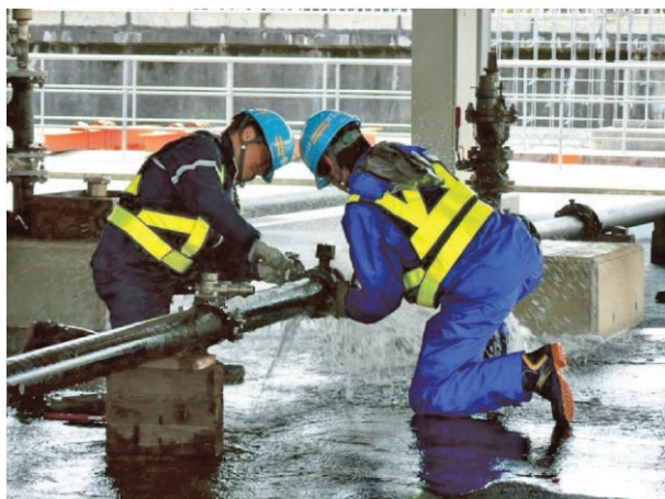
▲漏水修理作業の研修
