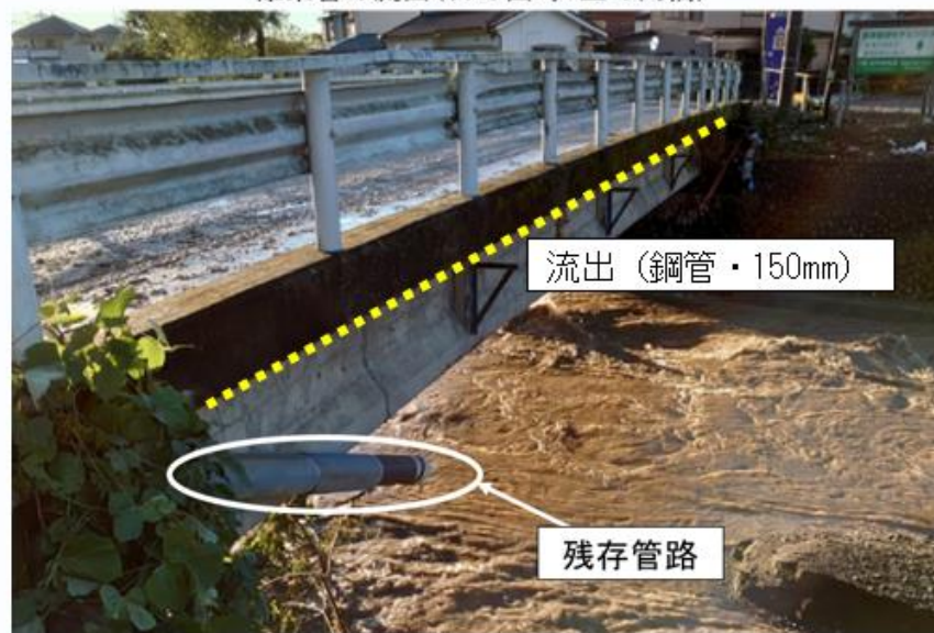
添架管の流出(日の出町:玉の内橋)
