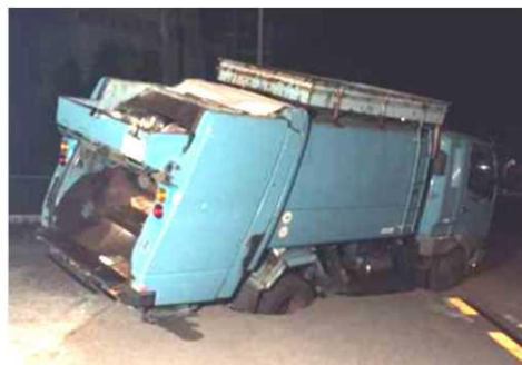
下水道等の老朽化による道路陥没
