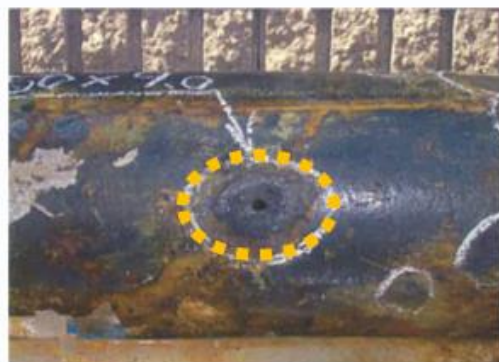
孔食の状況写真
