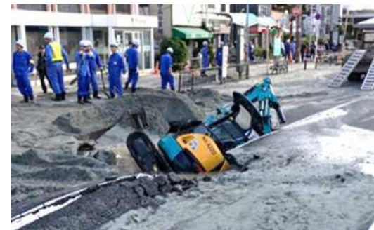
下水道等の老朽化による道路陥没
