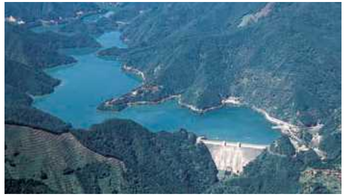
▲現在の小河内ダム(貯水池)
