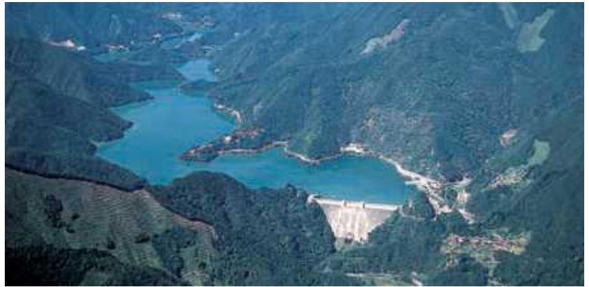
▲東京都の水がめ 小河内ダム (貯水池)
