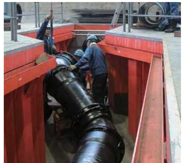
▲水道管をつなぎ合わせる作業の訓練
