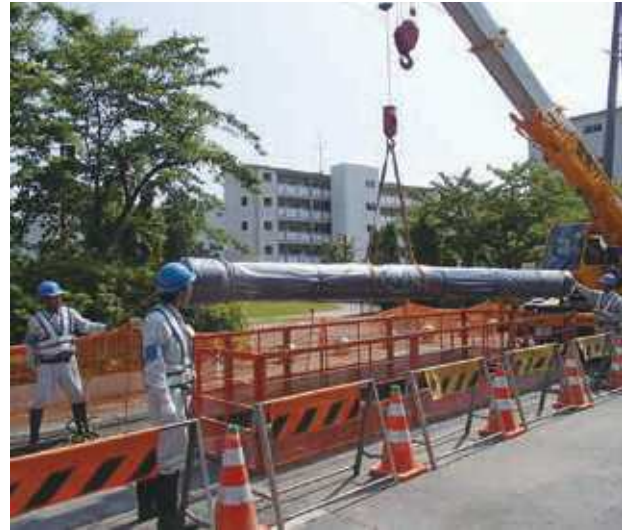
▲水道管取りかえ工事
