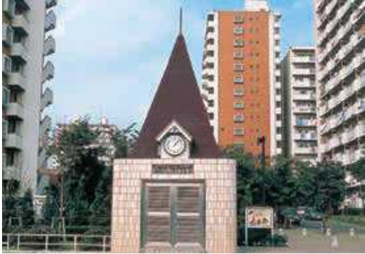
▲災害時給水ステーション（給水拠点）の地上部分 （この地下に応急給水槽があります。）（品川区立しお公園）
