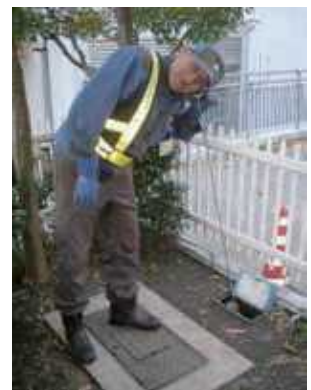
漏水調査の様子
