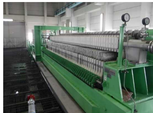
< 排水処理設備（脱水機） >
