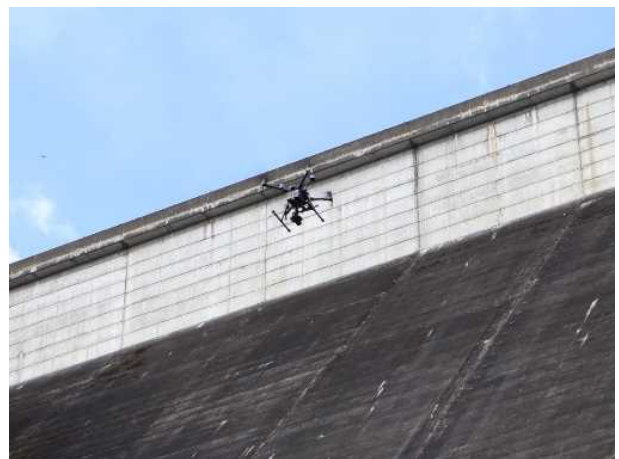
<ドローンによる貯水池堤体の点検>
