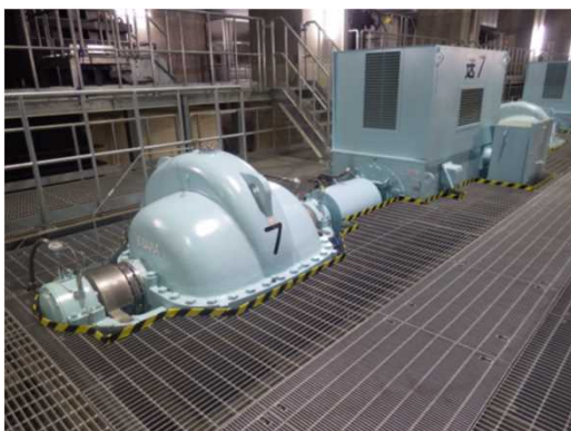
< 省エネ型ポンプ設備 >
