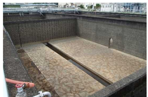
＜沈殿池の耐震化例＞
