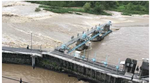
< 台風により増水し濁度が上昇した多摩川 >
