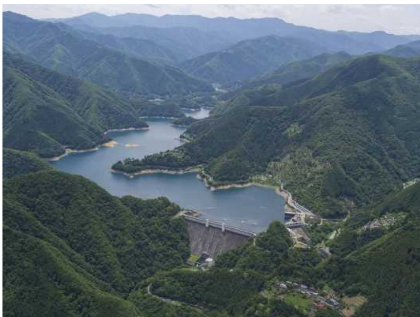
<小河内貯水池>
