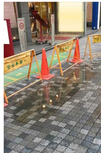
< 給水管漏水（舗装へ浸出） >
