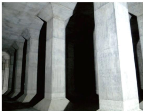
▲補強前の配水池
