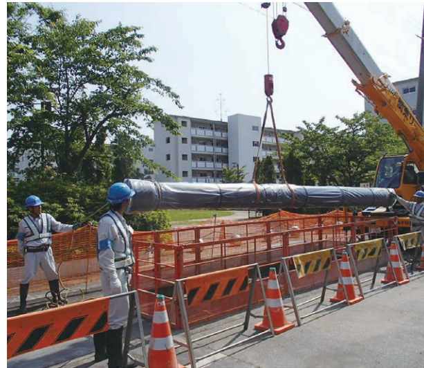
▲水道管取りかえ工事
