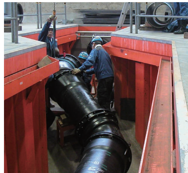
▲水道管をつなぎ合わせる作業の訓練 (水道局研修・開発センター、世田谷区)
