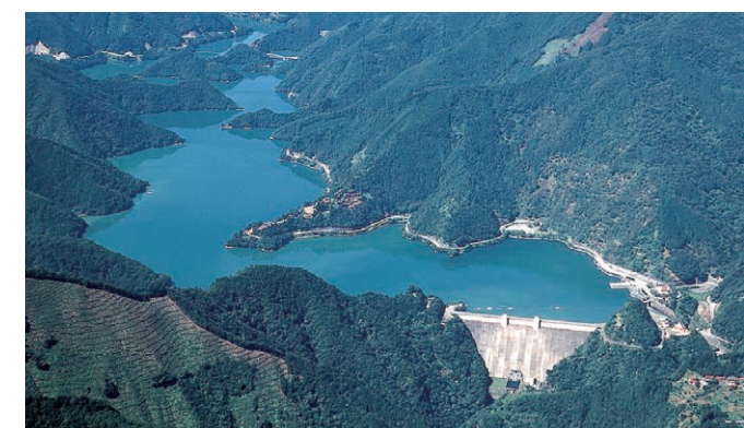
▲現在の小河内ダム（貯水池）
