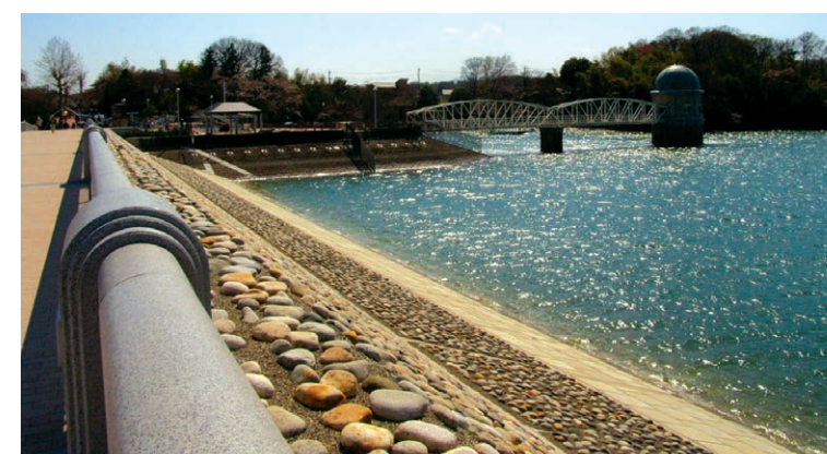
▲堤防の強化工事をした村山下貯水池(多摩湖)
