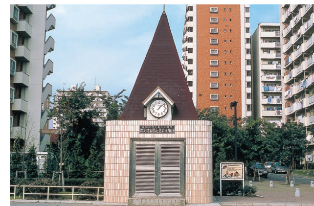
▲災害時給水ステーション（給水拠点）の地上部分（この地下に応急給水槽があります。）（品川区立しおじ公園）
