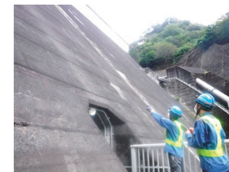
▲小河内ダム(貯水池)の点検・整備
