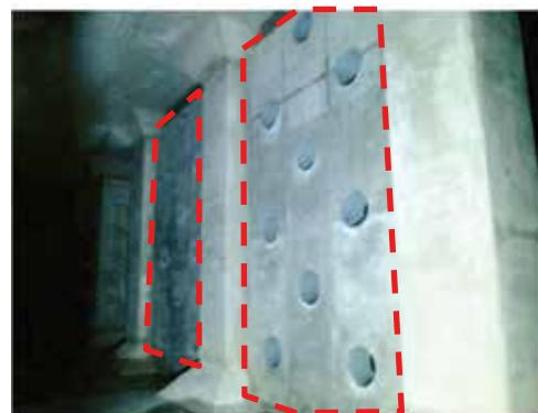
▲補強後（耐震壁の新設）
