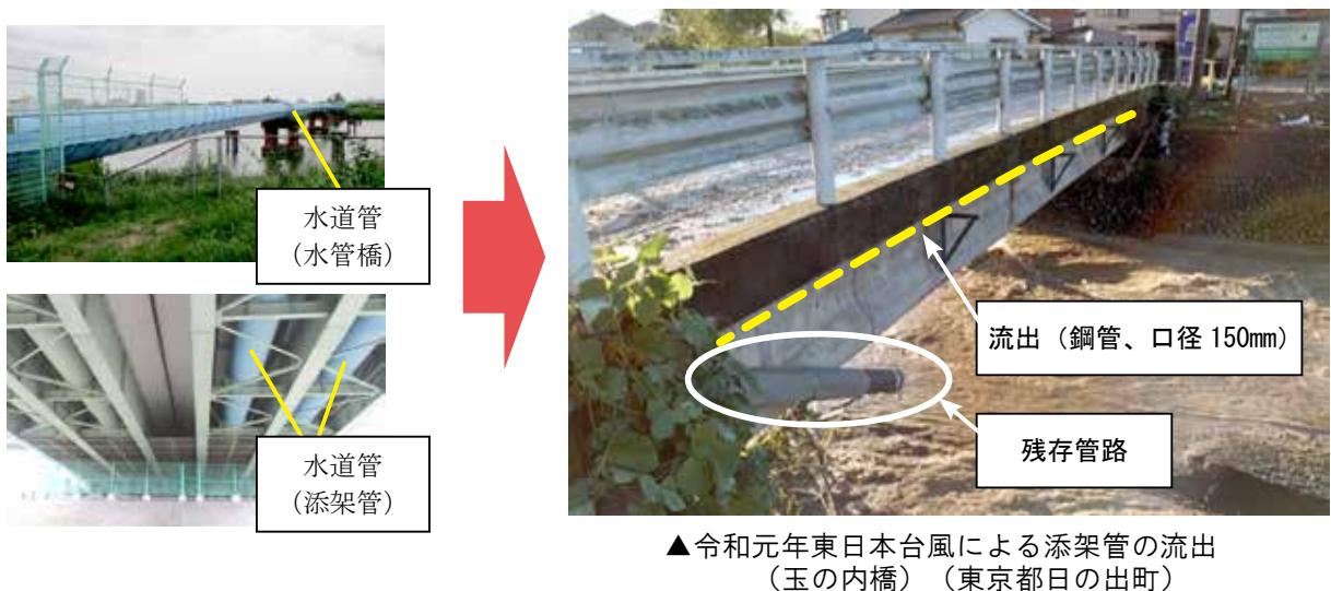
○水管橋や添架管の損傷、流出の被害を未然に防ぐため、水管橋等を地中化します。
