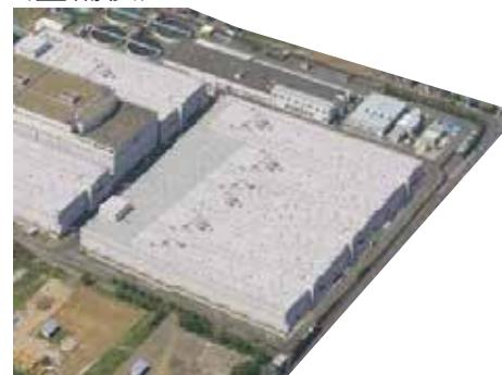
○更新までの間は、日量100万立方メートル以上の施設能力を有する濃水場や導水から送水まで自然流下により運用が可能な濃水場を対象として、開放面積が大きい沈殿池を経済性に優れた「シート型」で覆蓋化し、降灰も含めた異物混入対策を進めます。
