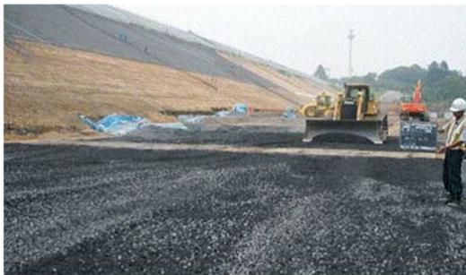
**Fig. 8:** Horizontal drain
