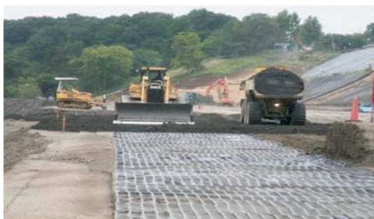
**Fig. 10:** Geotextiles
