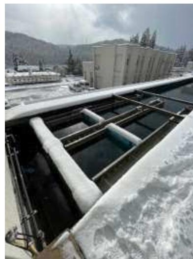
宝立浄水場沈殿池の損傷
