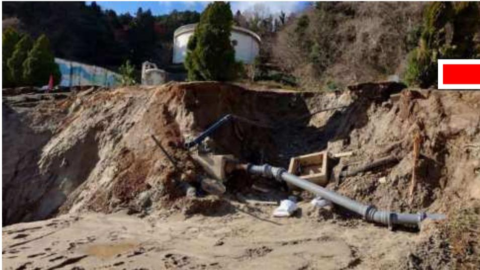
岩屋浄水場の土砂崩壊
