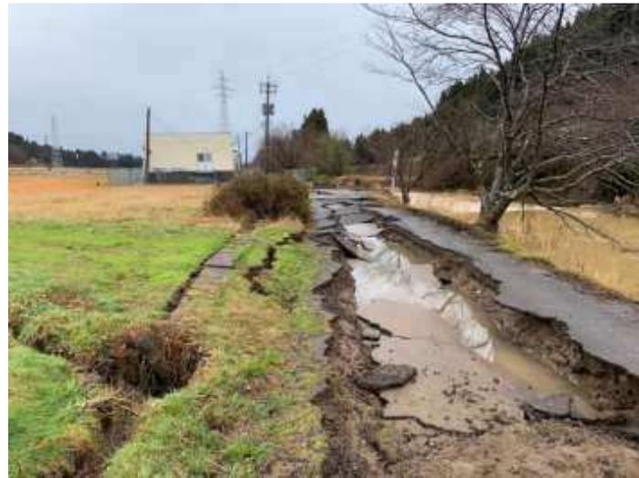
導水管の布設道路の崩壊
