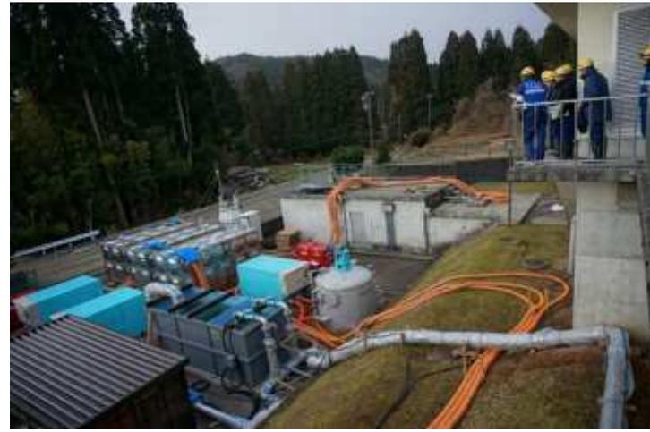
宝立浄水場内の可搬型浄水装置の設置
