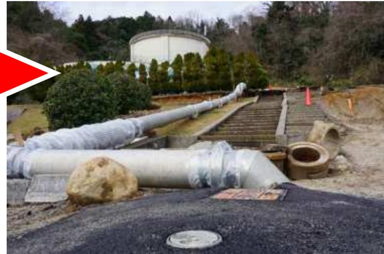
岩屋浄水場の構内配管の仮設管
