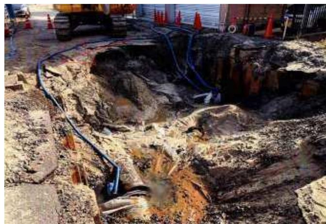
岩屋浄水場付近の主要な管路損傷
